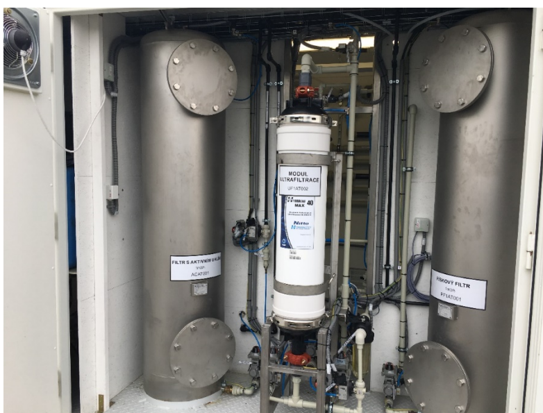
Obr. 2: Písková filtrace, membránová filtrace a filtr s granulovaným aktivním uhlím v poloprovodní jednotce pro recyklaci odpadních vod
